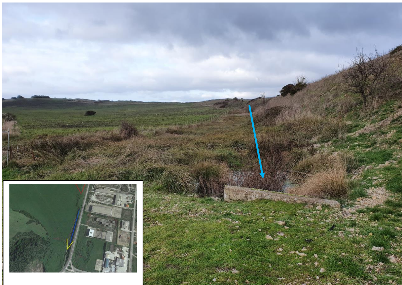
Figura 24: drenaggio acque provenienti dalla sede stradale (canalette trasversali del rilevato)
