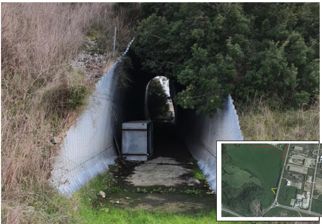
Figura 23: tubolare drenaggio acque dalla zona industriale e sottostante l'incrocio di ingresso
